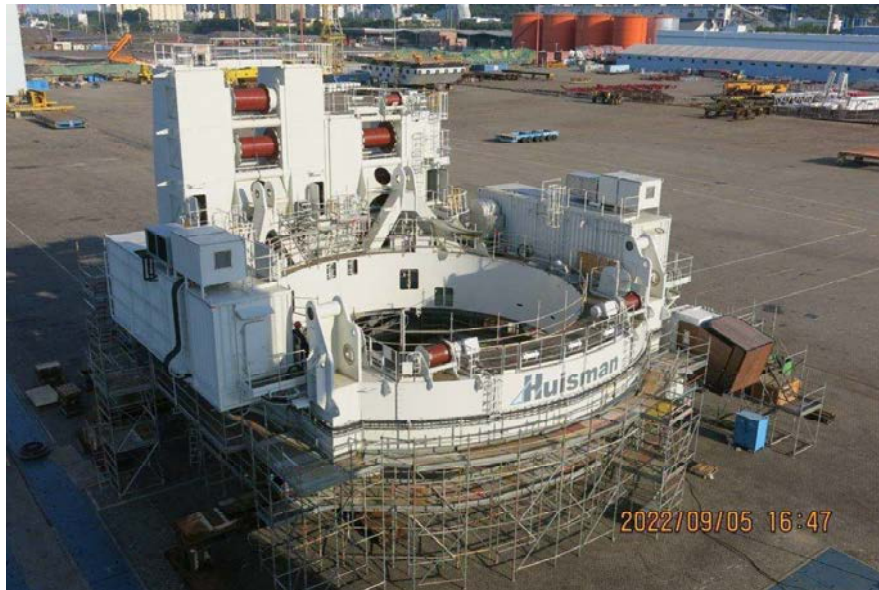
Huisman 2,200T Crane
